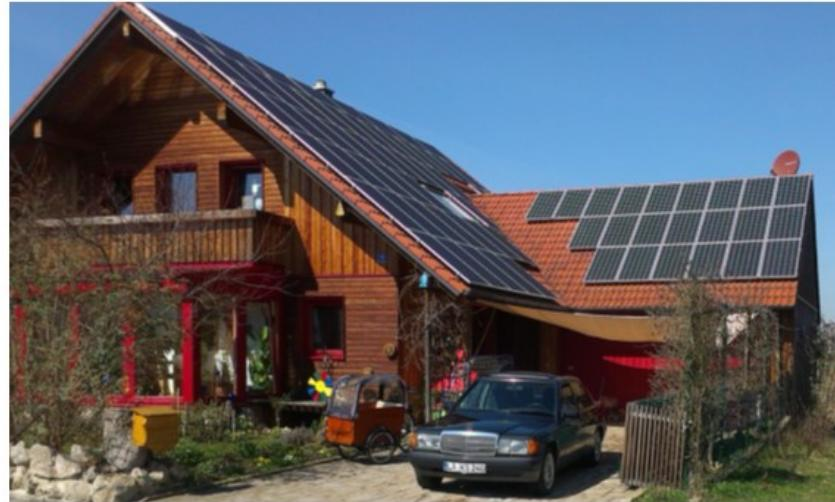
Solarthermieanlage mit 54 m<sup>2</sup> Indachkollektor und 11.500 Ltr. Pufferspeicher.
