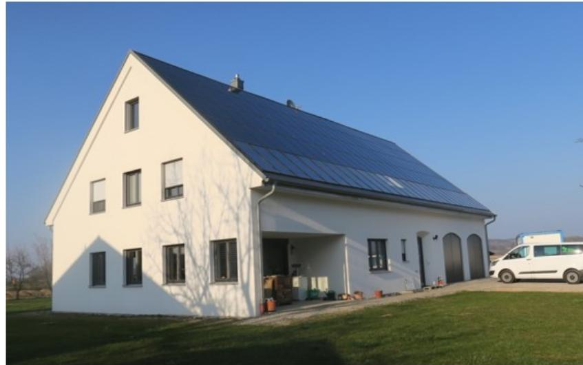
Solarthermieanlage mit 40,5 m<sup>2</sup> Indach-Kollektorfläche, 42 ° Dachneigung und 10.000 Ltr. Pufferspeicher.
