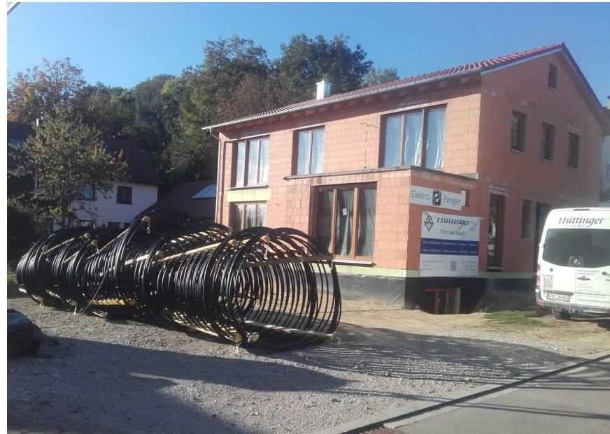
Wärmepumpe Erdreich/Wasser mit Erdkörben und 12 kW Heizleistung
